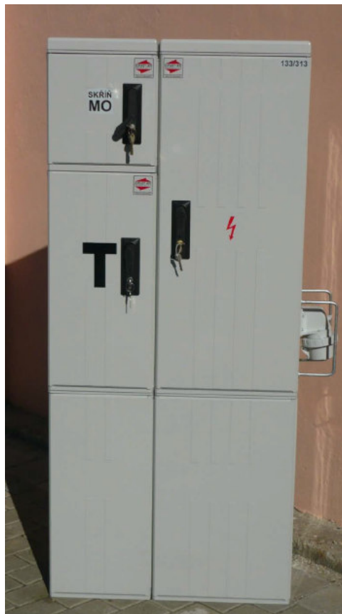
Obr.1 Vzor společné přístrojové skříňe pro přejezdy
